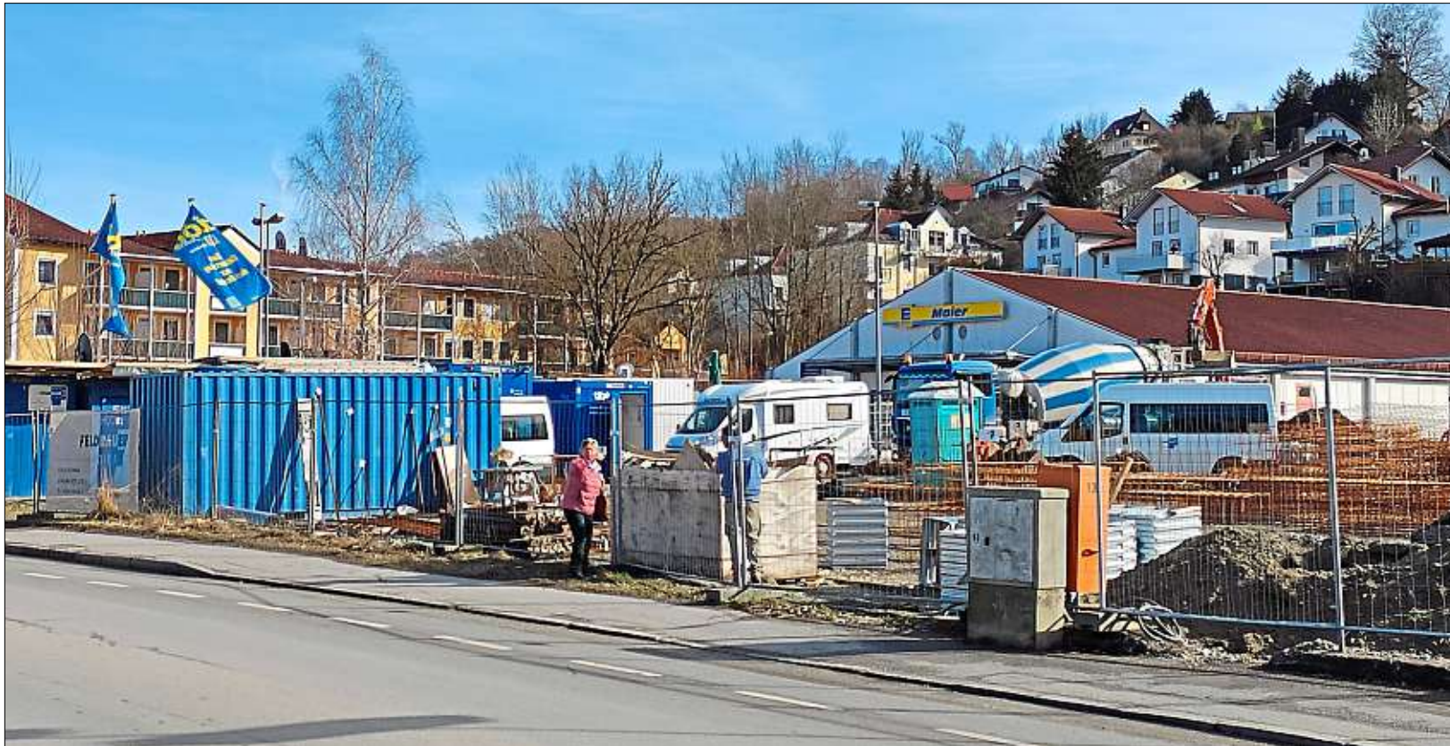
Kräftig gewerkelt wird auf dem Areal neben Edeka Maier in der Kapuzinerstraße. Hier entsteht ein neuer Edeka-Markt. Auf dem alten Gelände werden anschließend ein Getränkemarkt und eine Filiale der Drogeriemarkt-Kette Rossmann gebaut. – Foto: Stattenberger
